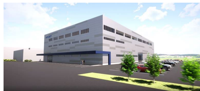
キッツエスシーティー 新田SC工場 新工場棟
