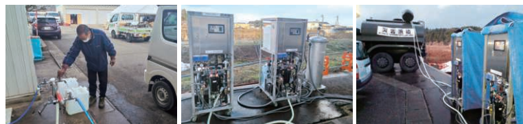
地域の給水拠点 アクアレスキュー設置状況 自衛隊への給水
