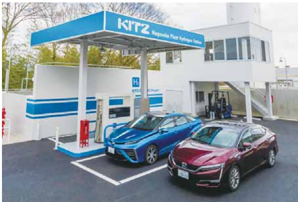
キッツ長坂工場水素ステーション(自家用)
