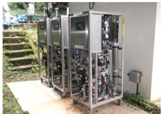
被災地に設置されたアクアレスキュー
