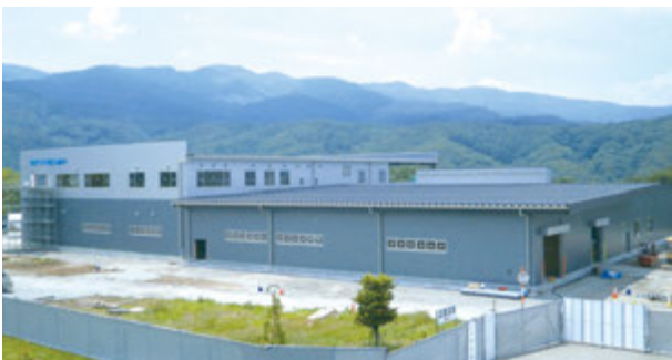
建設工事が進む新工場
