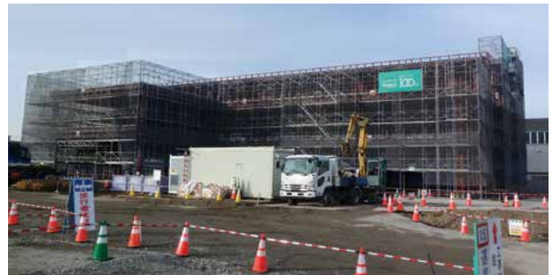
建設が進むKITZグループ イノベーションセンター
